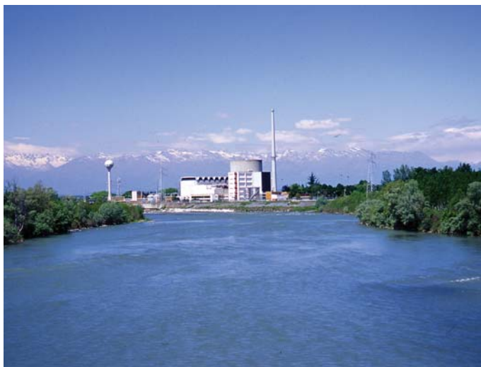
La ex-centrale nucleare «Enrico Fermi» a Trino Vercellese, in riva al Po: con una potenza di 260 MW, è rimasta attiva dal 1965 al 1990, dopodiché è stata chiusa a seguito del referendum del 1987. In passato altre centrali nucleari hanno funzionato a Latina (153 MW, dal 1964 al 1987), Sessa Aurunca (Caserta, 150 MW, dal 1964 al 1982) e Caorso (Piacenza, 860 MW, dal 1981 al 1990).
