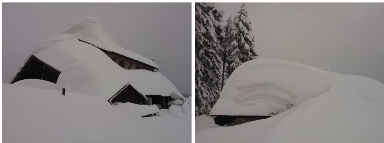
Figure 37a 37b Il 2 marzo 2014 il Rifugio Campogrosso (1457 m s.l.m.) e la sua dépendance sono sepolti sotto più di 3 m di neve. La modalità di deposito della neve sul tetto del rifugio testimonia la presenza di forti venti sud orientali durante la nevicata.
