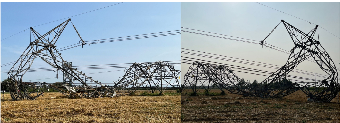
Fig. 26: Danni del tornado su un traliccio dell'alta tensione tra Voltana e Alfonsine. Fonte: Nicola Pirondini
