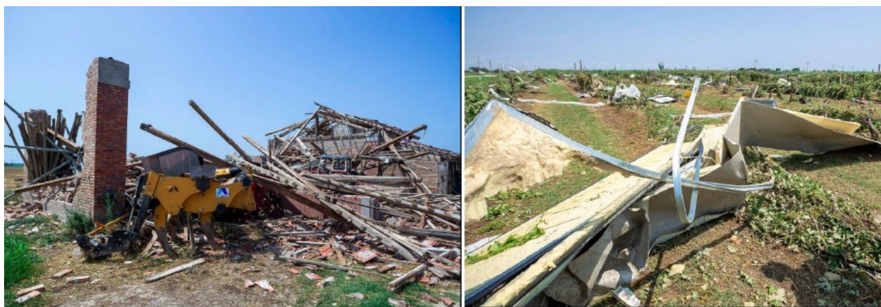
Fig. 31: Fabbricati gravemente lesionati (sn) e infrastrutture agricole distrutte (ds). Fonte: Foto Zani Il Resto del Carlino
