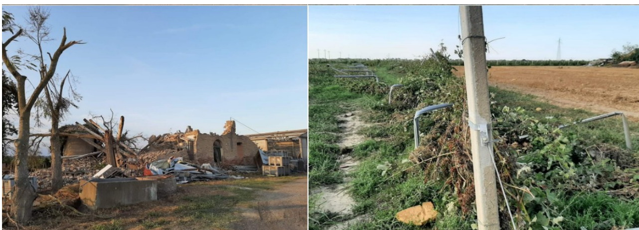
Fig. 29: Fabbricato demolito (sn) e danni incrociati (ds) tra Voltana e Alfonsine. Fonte: pagina fb E-R Meteo
