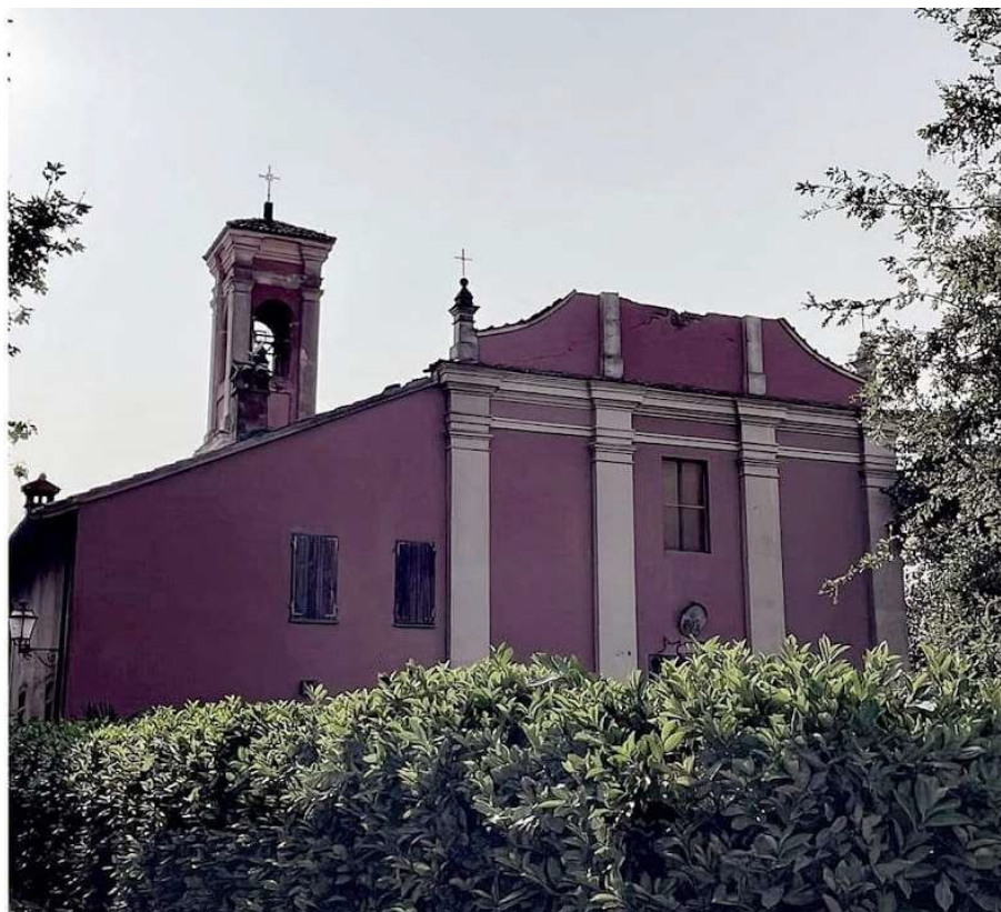
Fig. 30: Chiesa di San Giuseppe di Chiesanuova (Voltana) gravemente lesionata. Fonte: SOS Ravenna sicurezza
