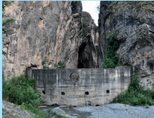
*Vista da monte della briglia filtrante ad arco realizzata nel 1977 sul Prebec all'imbocco superiore dell'Orrido di Chianocco, a protezione dell'abitato. Dall'epoca non si sono più verificati eventi distruttivi a valle (f. DCB).*
