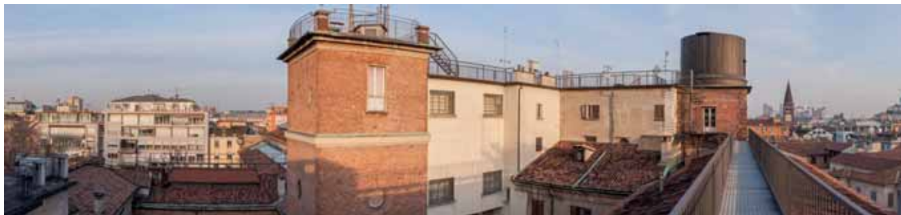
1. Panoramica del tetto dell'Osservatorio Astronomico di Brera (f. M. Carpino).
