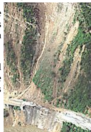
Un derrumbe y luego la ruta queda destruida. Venezuela. Fuente: El Universal
