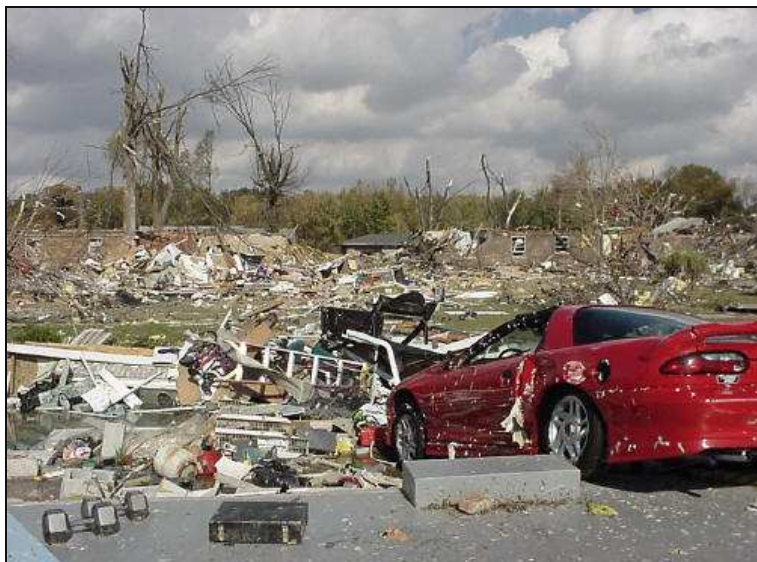
Nei pressi di Evansville dopo il passaggio del tornado F3.
