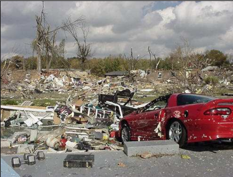
Nei pressi di Evansville dopo il passaggio del tornado F3.
