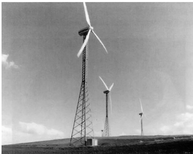
Fig. 5 - Aerogeneratori a tre pale
